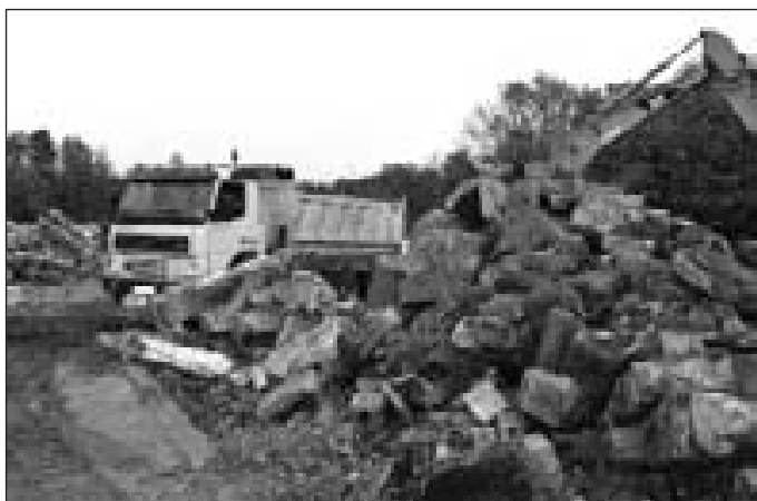
Tausende Kubikmeter Bauschutt müssen abtransportiert werden
