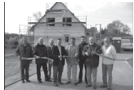
Kontrollgang über die Straße durch das neue Wohngebiet Wiesenblick. Die Erschließung ist abgeschlossen.
